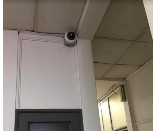
Instalación de nuevas cámaras de vigilancia para mejorar las condiciones de seguridad, tanto para los trabajadores y usuarios de la red. $ 5.959310.-
