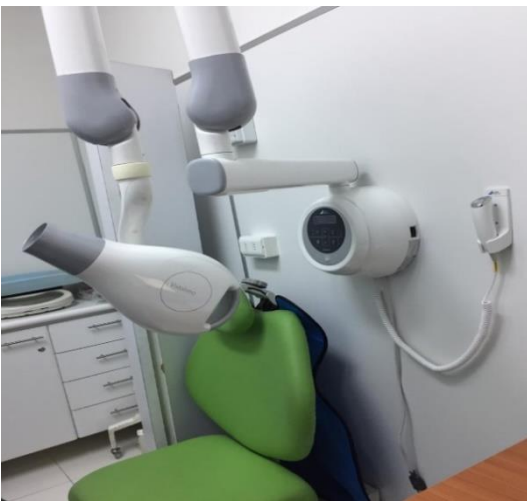
Implementación de Nueva sala de Rayo dental, que contempla equipos nuevos y mobiliarios. $15.000.000.-.
